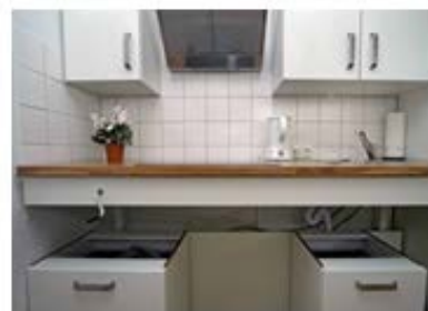
Küche: höhenverstellbare und unterfahrbare Arbeitsplatte, hier im Niedrigpreissegment
